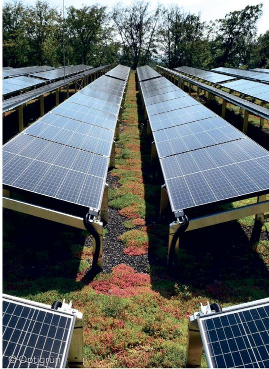
Eine Kombination von Dachbegrünungen und Solaranlagen ist möglich und führt neben den positiven Effekten wie Wasserrückhalt und Steigerung der Artenvielfalt durch die Kühlfunktion der Begrünung zu einer Ertragssteigerung der Module. Somit fordern immer mehr Städte die Umsetzung von Solargründächern.
